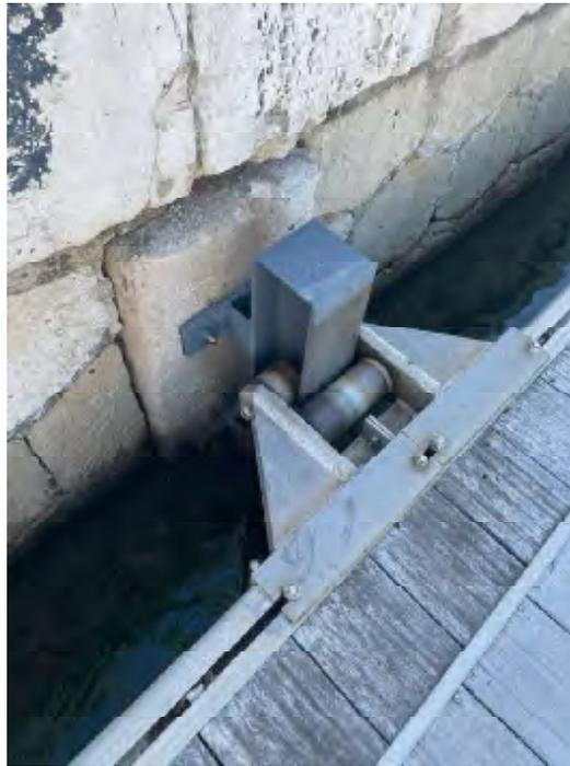
Imagen de referencia de anclaje de pantalán sobre muro existente
