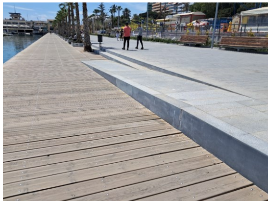
Imagen obras finalizadas en Muelle 1
