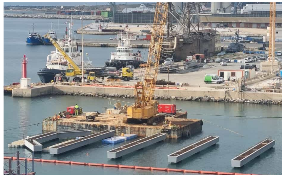
Imagen ejecución obras: Vigas prefabricadas UHPC
