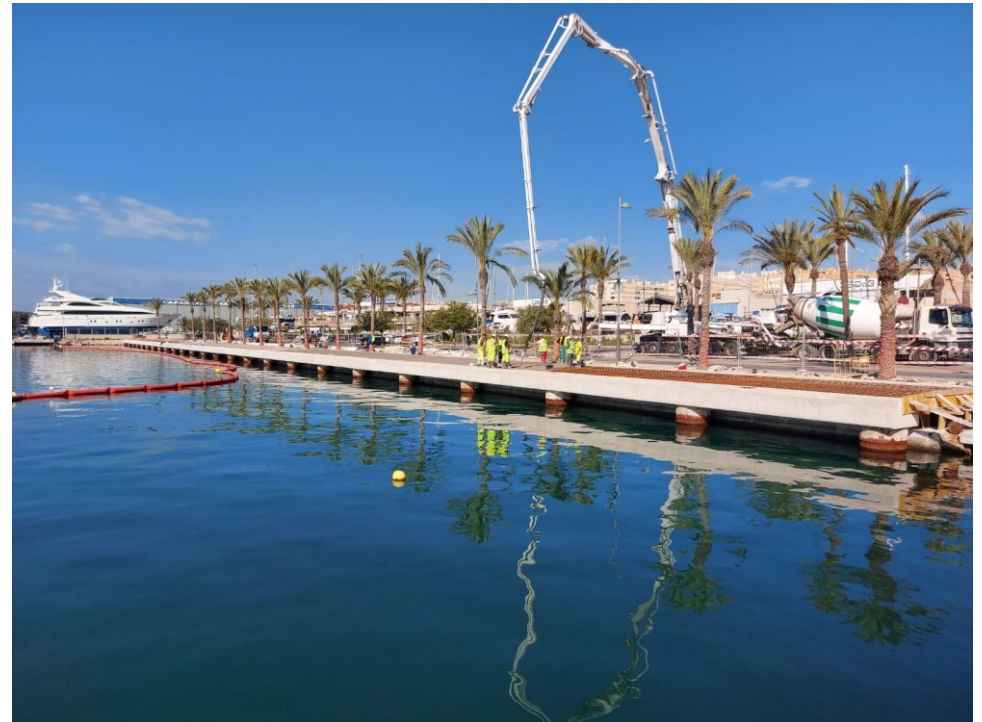
Imagen hormigonado losa Muelle C
