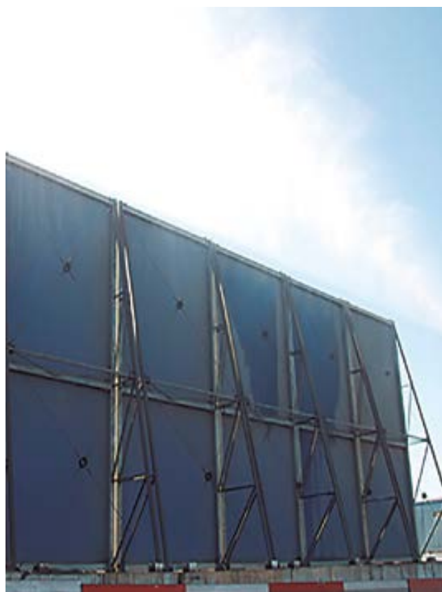
Descarga a primera línea protegida por pantalla atrapa polvo y cañones atomizadores.
