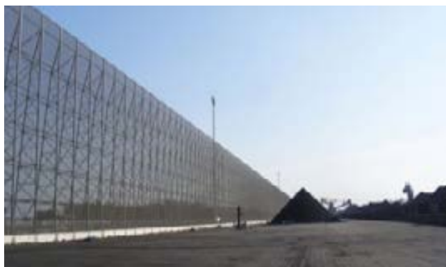
Parque de graneles protegido por barrera cortavientos.
