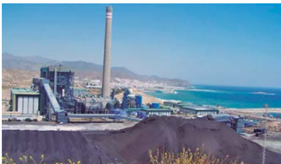
Terminal concesionada de Endesa en el Puerto de Carboneras. Detalle del muelle, del sistema de transporte horizontal y del parque de carbones.
