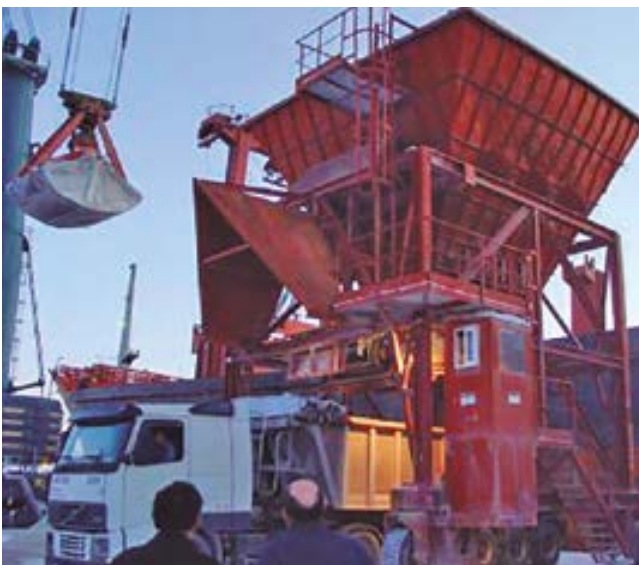
Descarga con grúa-tolva-camión.
