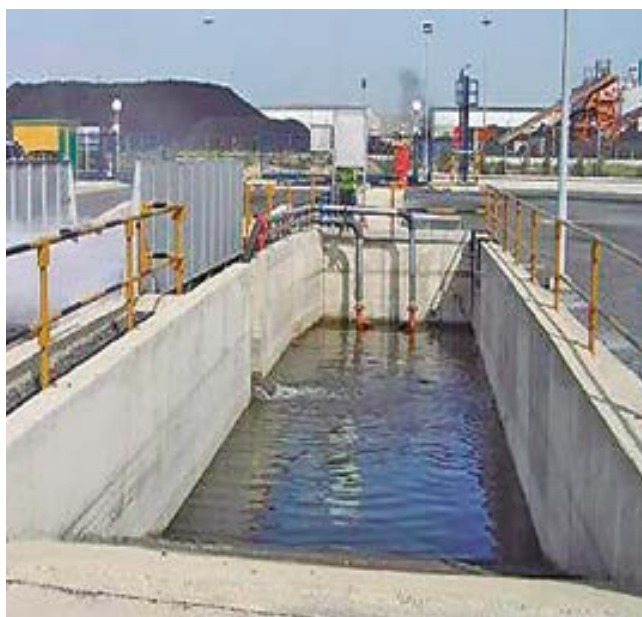
Lavaruedas con balsa de decantación y rampa de acceso a la misma
