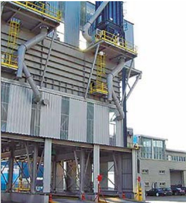
Cargadero de camiones con tolvas telescópicas dotadas de aspiración y filtrado
