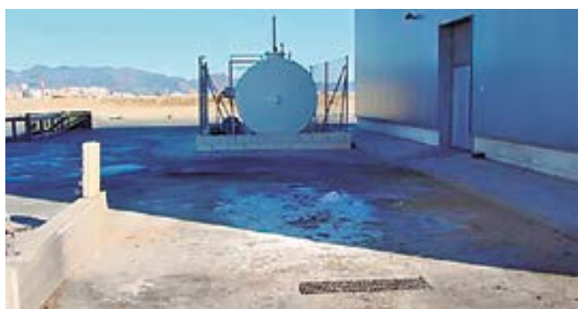
Área de lavado de maquinaria con recogida y tratamiento del agua por decantación y separación de hidrocarburos
