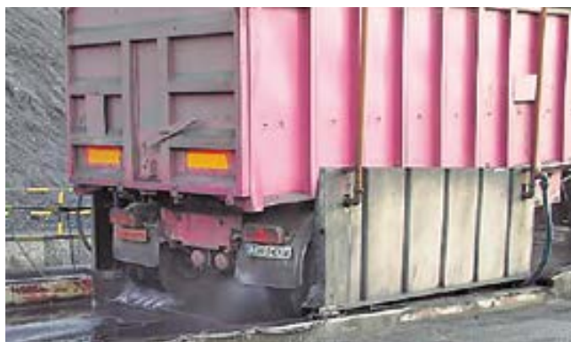
Los sistemas lavaruedas a la salida de parques de graneles limitan la dispersión de partículas por rodadura.
