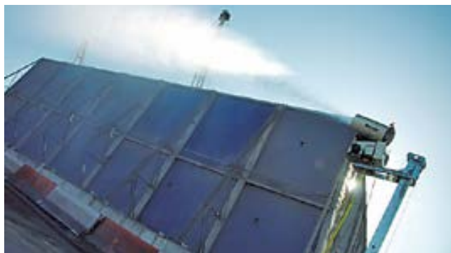
Zona de acopio temporal en muelle protegida por pantallas y cañones nebulizadores.
