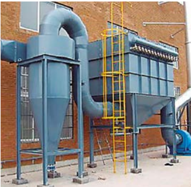
Prefiltrado mediante ciclón.
