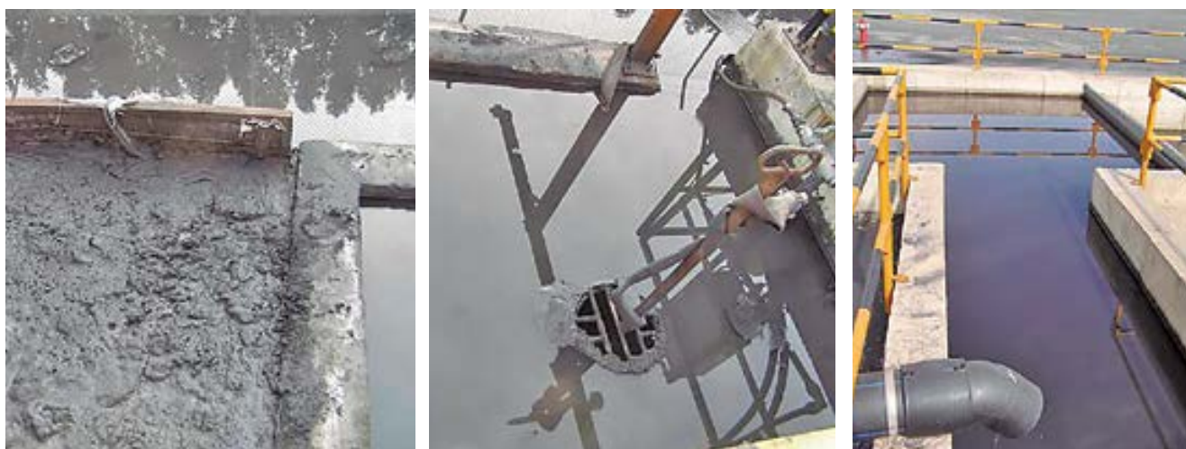
Decantación mediante floculantes y retirada de flotantes (izquierda y centro). Balsa de decantación secundaria (derecha)
