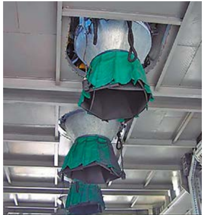
Cargadero de camiones con tolvas telescópicas dotadas de aspiración y filtrado
