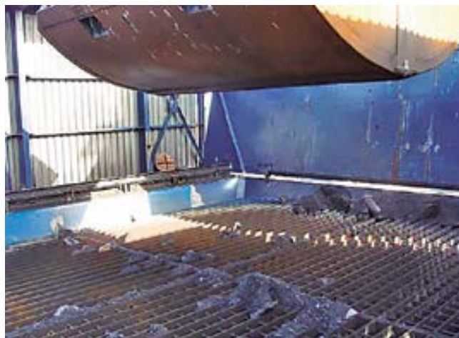
Pantallas en tolva de pórtico descargador protegiendo del viento la apertura de la cuchara.
