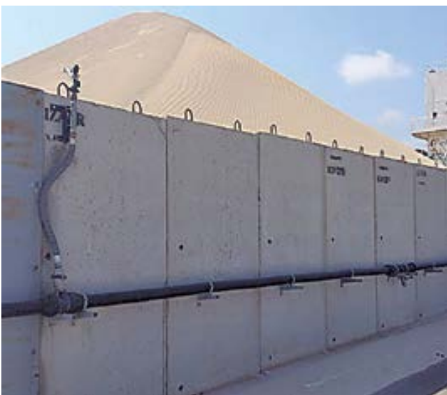
"Muro móvil" acotando acopio en primera línea con sistema de pulverización de agua.
