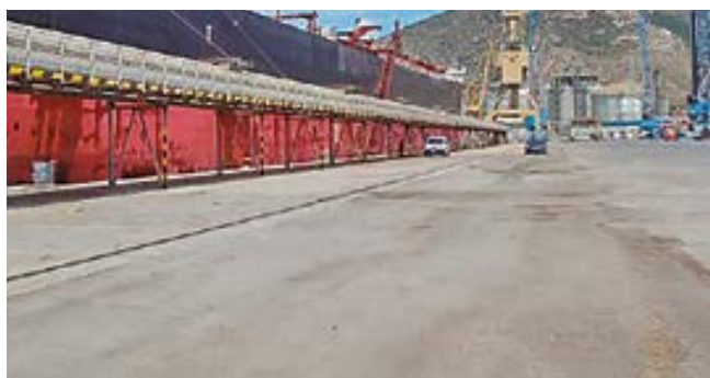
Cintas elevadas paralelas al cantil.
