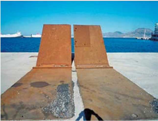
Detalles constructivos de rampas atrapa derrames
