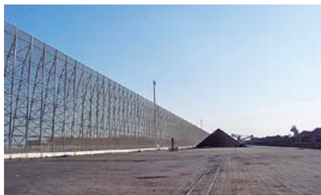
Parque de graneles protegido por barrera cortavientos.
