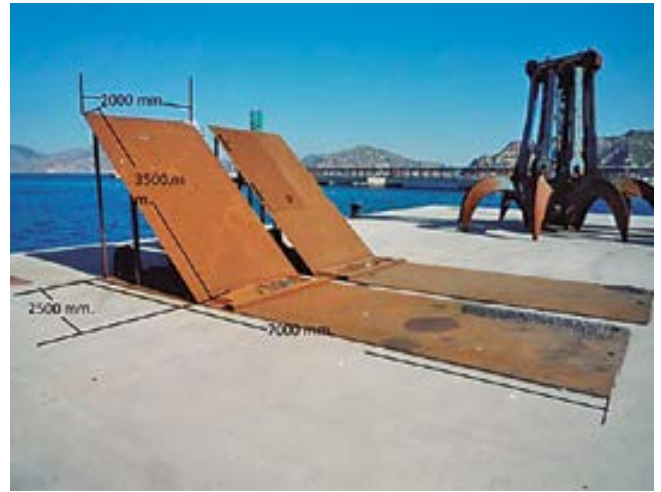
Detalles constructivos de rampas atrapa derrames
