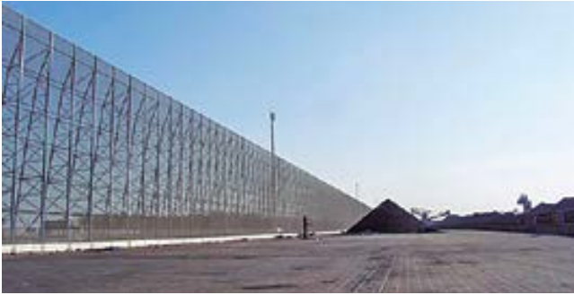
Pantallas corta-vientos en zona de acopio.
