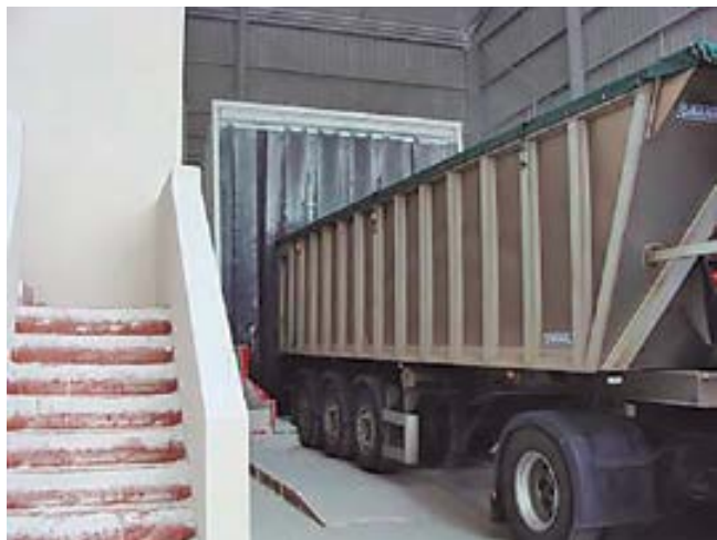
Zona de descarga de camiones apantallada.
