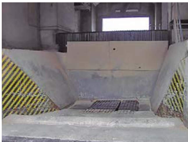
Tolva de descarga para camiones, en recinto cubierto
