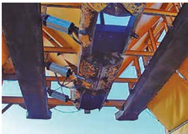
La descarga de productos fluyentes a camión se realiza directamente mediante tajaderas
