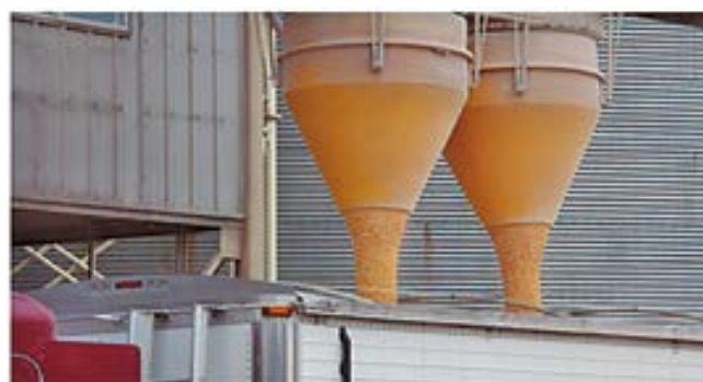
Cargadero de camiones.
