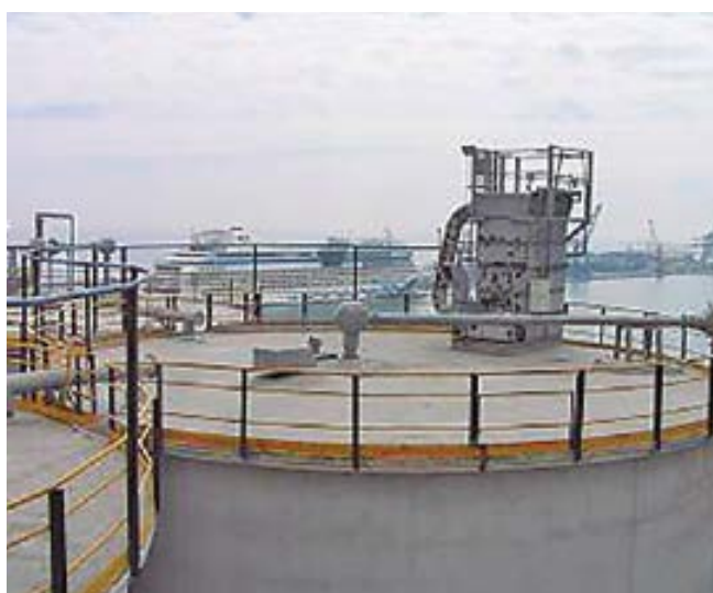
Filtro de partículas en la salida de aire de un silo cargado mediante sistemas neumáticos.
