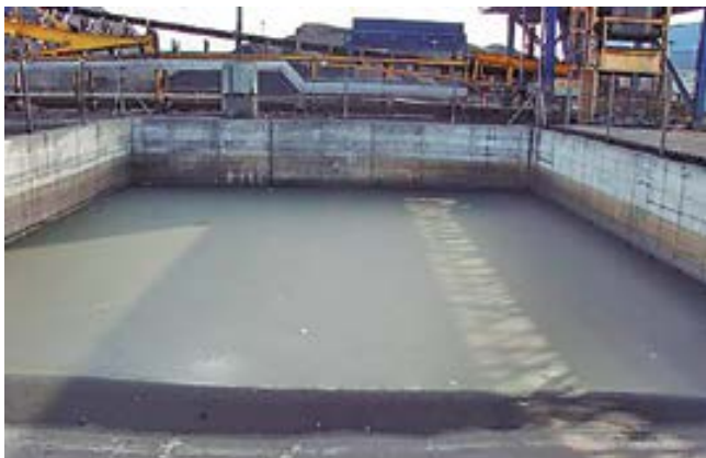
Piscina de decantación de aguas pluviales y riego recogidas en campos de carbón.
