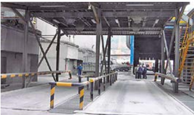
Cargadero de camiones con bascula que previene retornos por sobre carga.
