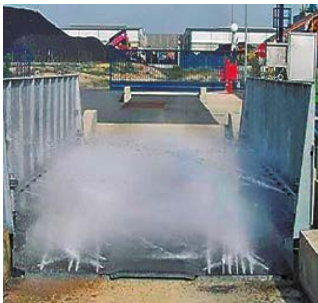
Lavaruedas con balsa de decantación y rampa de acceso a la misma
