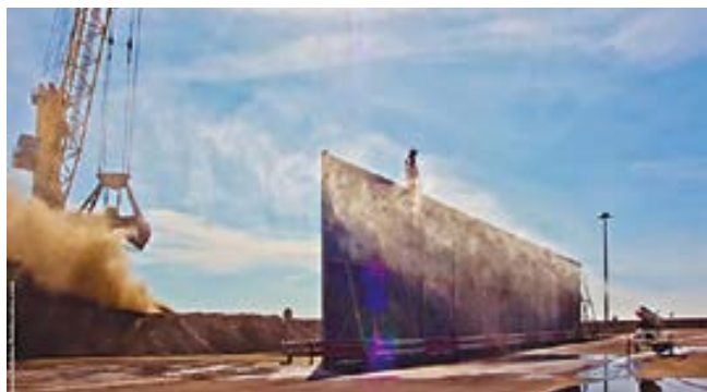
Zona de acopio temporal en muelle protegida por pantallas y cañones nebulizadores.
