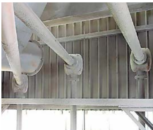
"Codos" en tuberías neumáticas
