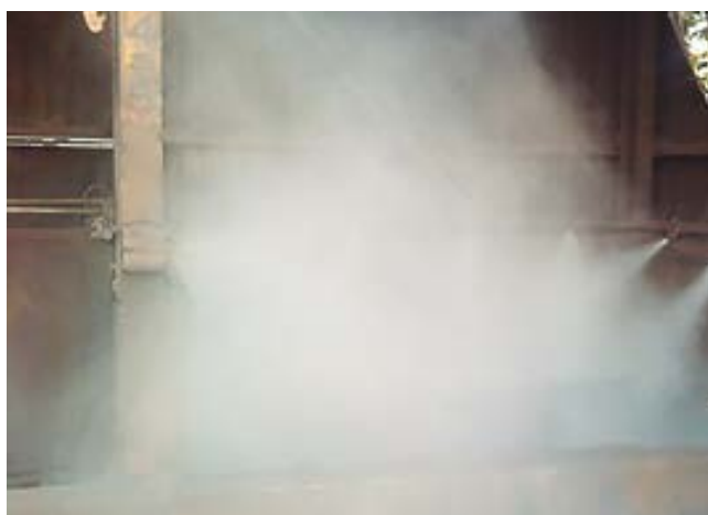
Control de emisiones en descargadero de vagones y en descargadero de camiones por agua nebulizada.
