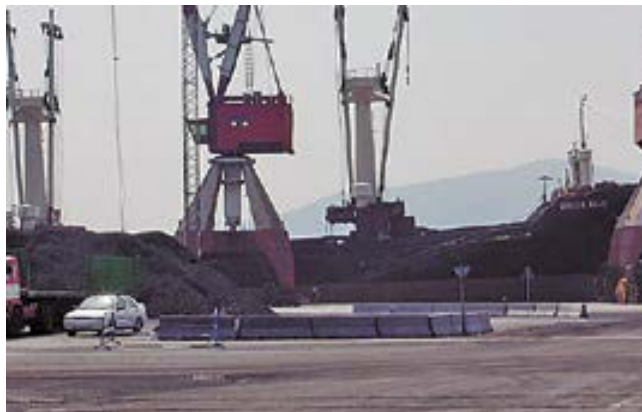
Delimitación de viales en zonas de acopio.
