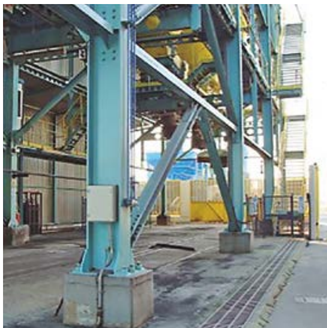
Cargadero de vagones mediante tolva telescópica.
