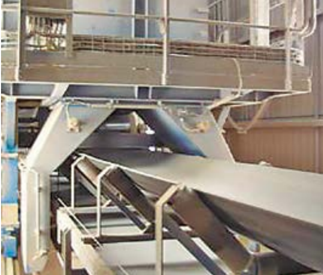
Posibles atascos en rodillos, o falta de lubricación de partes móviles pueden ser fuentes de ruidos.
