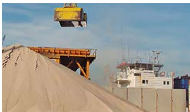
Delimitación de acopios mediante muros móviles.
