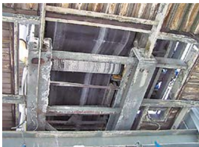
Cinta retráctil de entrada del descargador. La cinta de muelle vierte sobre la cinta de entrada mediante un tripper
