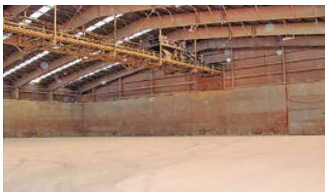
Descarga cenital desde cinta con tripper y descarga desde cinta con tripper y tolva telescópica. La tolva telescópica de cascada limita la emisión de partículas y el deterioro de la mercancía.
