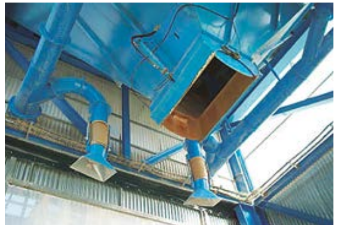
Tolva con zona de carga de camiones carenada y aspiración en el recinto
