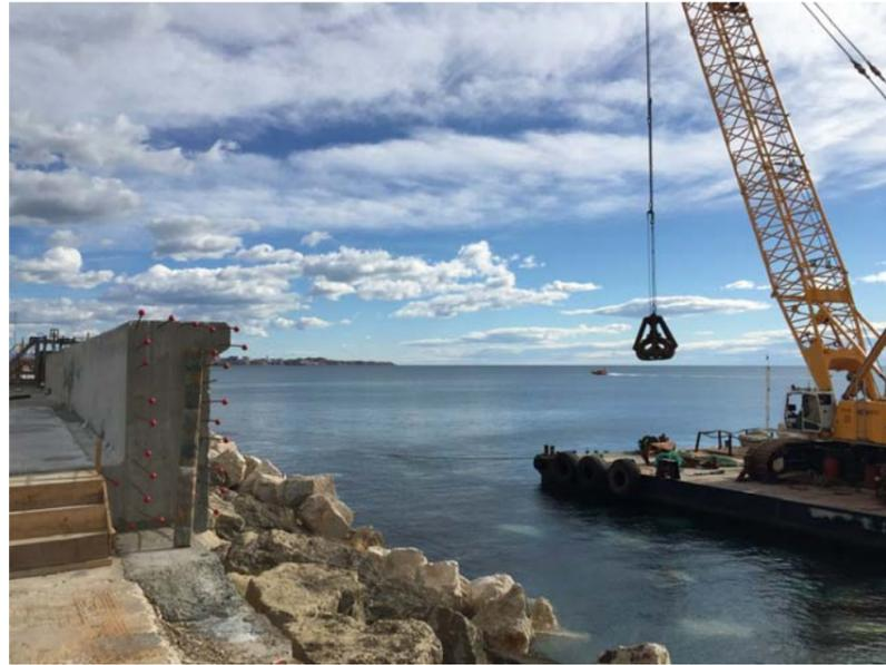
En el año 2003, la Autoridad Portuaria de Alicante encargó al CEDEX, a través del Ente Público Puertos del Estado, la auscultación del dique de Levante, para comprobar el estado de los distintos elementos que lo conforman, en especial el manto de protección, y en su caso proponer las correspondientes obras de reparación. En dicho trabajo se comprobó el estado de conservación del dique de Levante con el objeto de determinar la necesidad de efectuar obras sobre el mismo.
