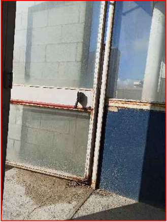
Filtración agua en caja de escaleras
