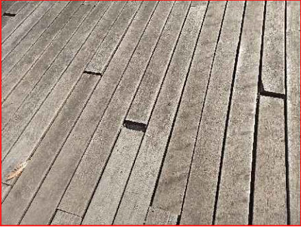
Levantar listones y revisar rastreles
