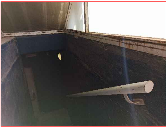
Filtración agua en caja de escaleras
