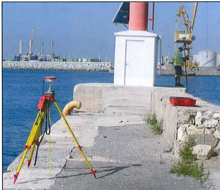
Figura 15 Antena GPS fija Leica para el levantamiento topográfico y antena de referencia móvil (en Base PA-6).
