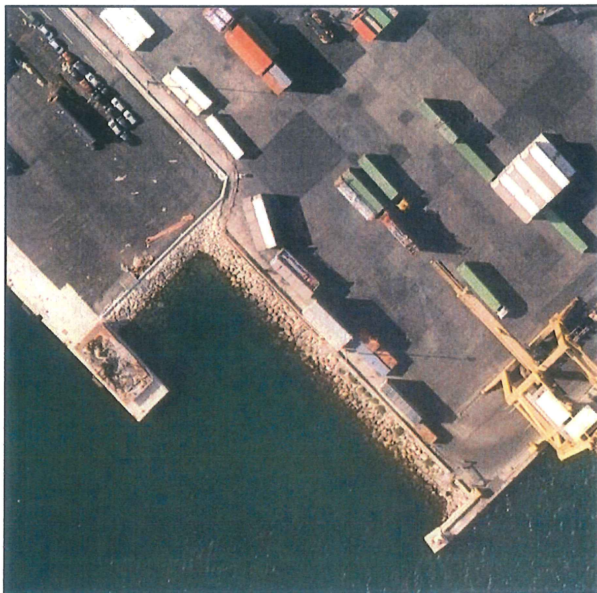
Figura 19 Zona de levantamiento en muelles 11y 13
